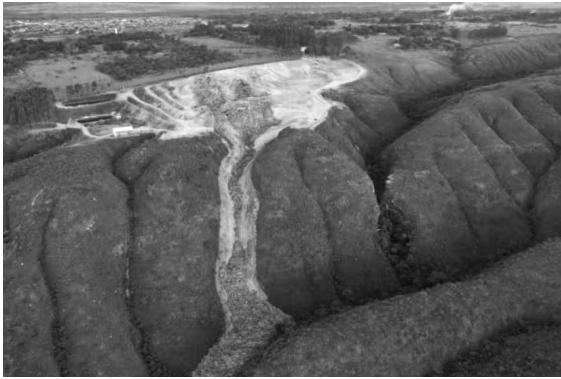
Foto: Desabamento do lixão em Padre Bernardo (GO)
